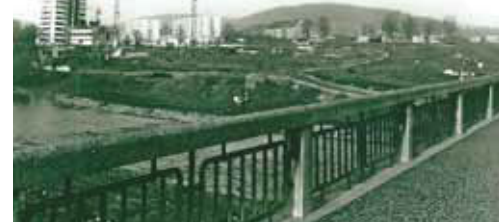
Výstavba sídliště 1. Máje
