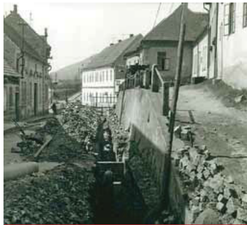
Pokládání kanalizace v Bavorovo ulici.
